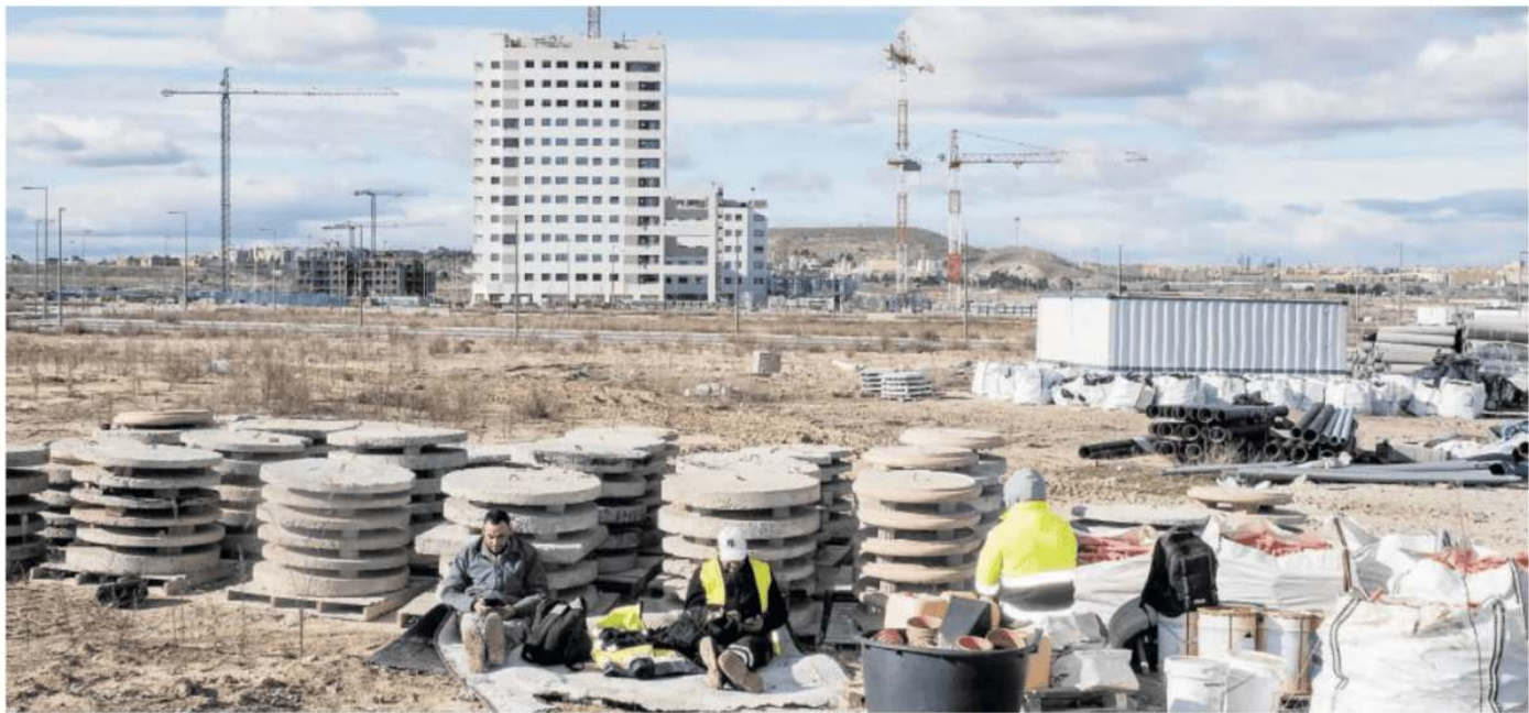
Edificios en construcción en el barrio de los Berrocales (Madrid). DAVID EXPÓSITO
